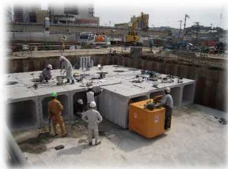
BOX型雨水貯溜槽への適用例 内幅1200×内高1200mm (ボックスどうしは耐震接続「TBタッチポイント工法」)
