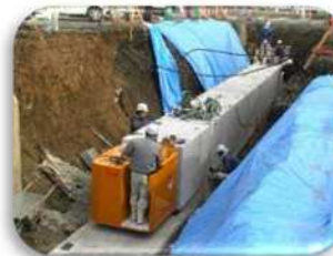
据え付け状況
