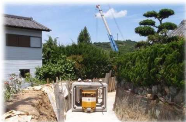
住宅密集地への適用例 (水路) 内幅 1600×1300
