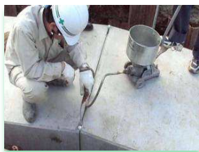
頂版から注入
