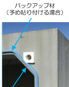
バックアップ材 (予め貼り付ける場合) 高弾性接着剤の充填部 (内目地)
