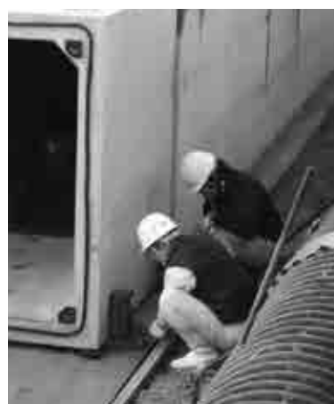
爪付きジャッキによる据付け
