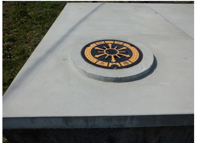
■防火水槽ふた設置工事 10kN/m 2 (L)3500 × (B)2000 × (t)130 等
