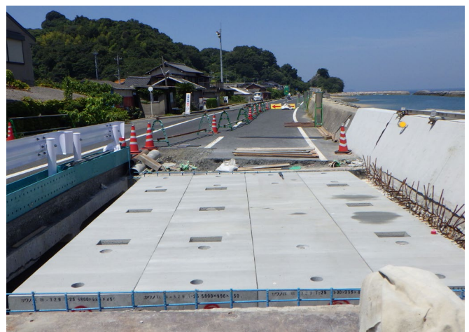
■一般国道437号 橋梁補修工事
