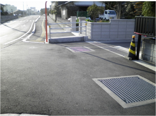
■市道くし山線 道路改良工事
