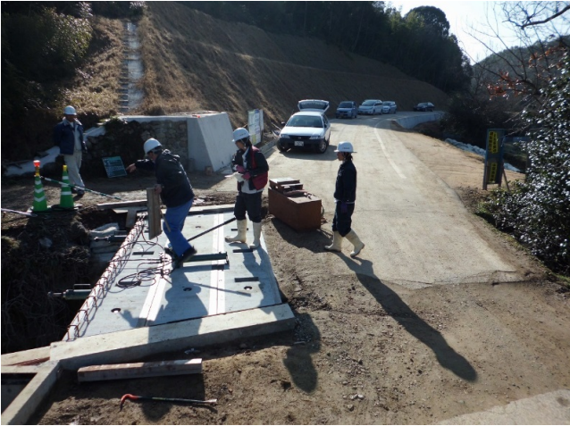
■免地東本郷線 道路改良工事
