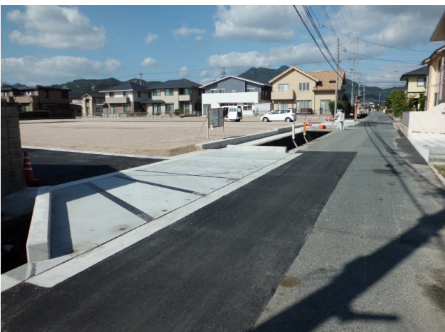
■防府市 某民間 宅地造成工事
