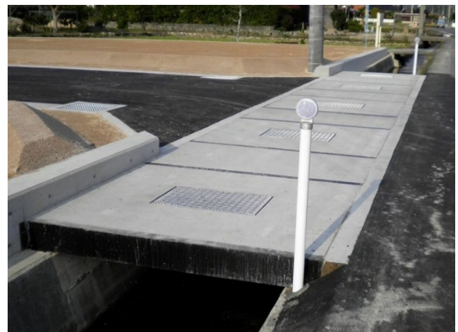
■山口市 某民間 宅地造成工事
