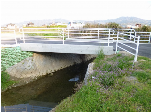
■清水橋 橋梁架け替え工事 T-14 (L)8500 × (B)1000 × (t)320
