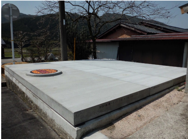
■防火水槽ふた設置工事 10kN/m 2 (L)3500 × (B)2000 × (t)130 等
