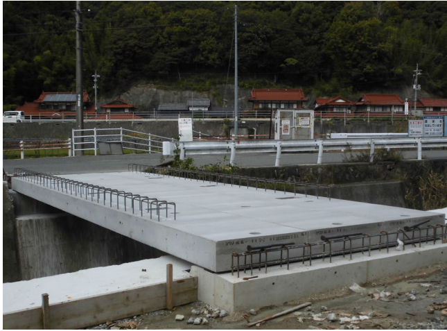
■木谷郷川 橋梁災害復旧工事（広島県）
