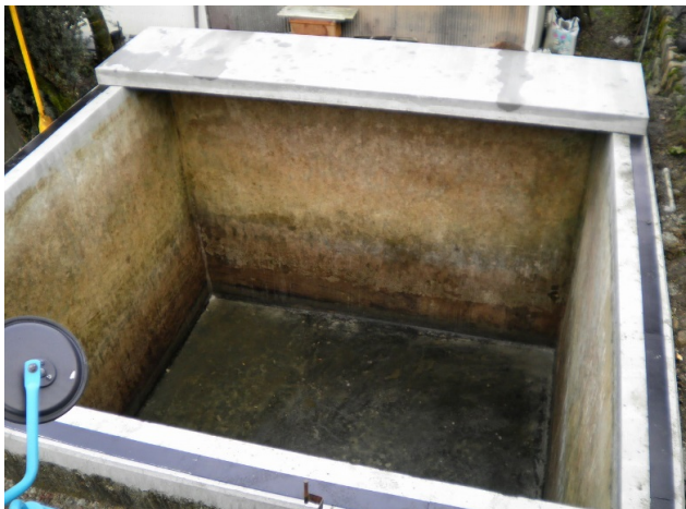
■防火水槽ふた設置工事 10kN/m 2 (L)4500 × (B)1500 × (t)150 等
