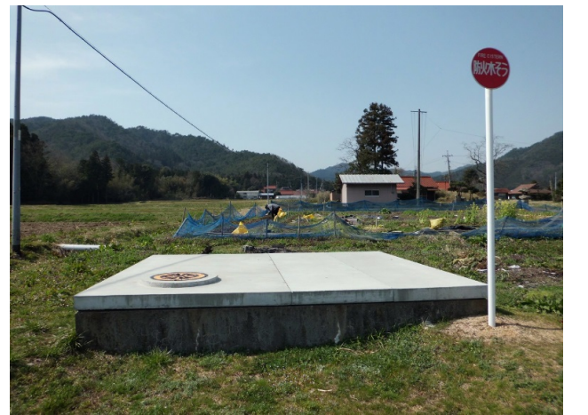
■防火水槽ふた設置工事 10kN/m 2 (L)4500 × (B)1500 × (t)150 等
