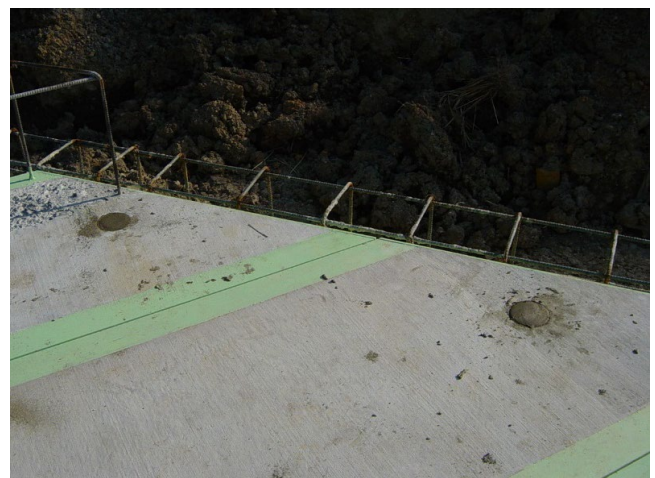
■ HC床版設置工事 施工状況 T-25 (L)9448 × (B)1294(995) × (t)380
