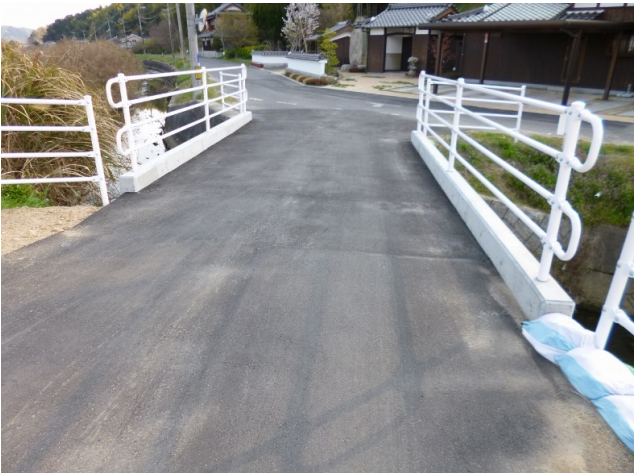
■清水橋 橋梁架け替え工事 T-14 (L)8500 × (B)1000 × (t)320
