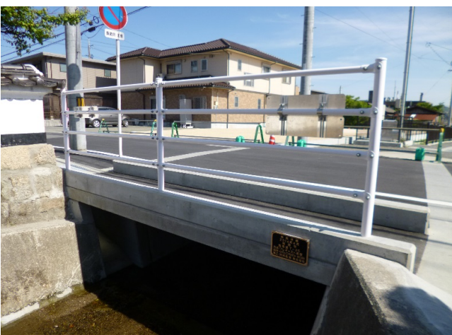
■市道川崎・平野線(浄真寺橋) 改修工事
