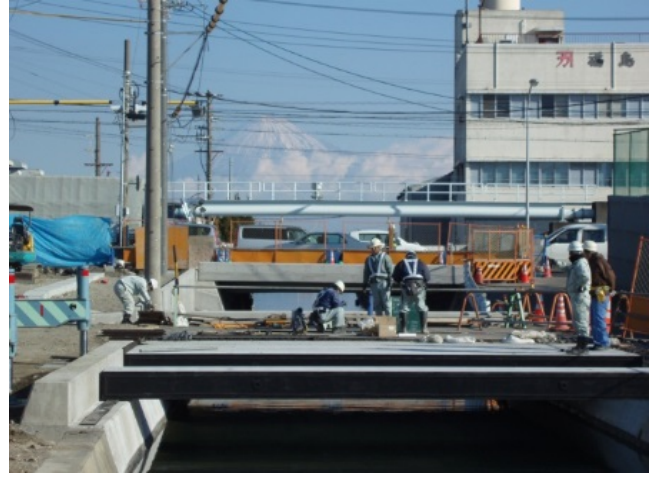
■清水駒越SC 新築工事（静岡市）
