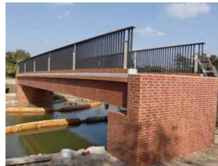
沖縄県総合運動公園 橋桁側面化粧パネル
