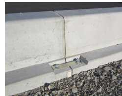
モルタル充填前
