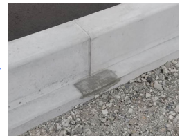
モルタル充填後
