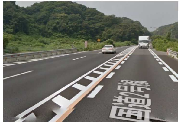
国道2号線 戸田拡張工事（置き式） 国土交通省 山口河川国道事務所
