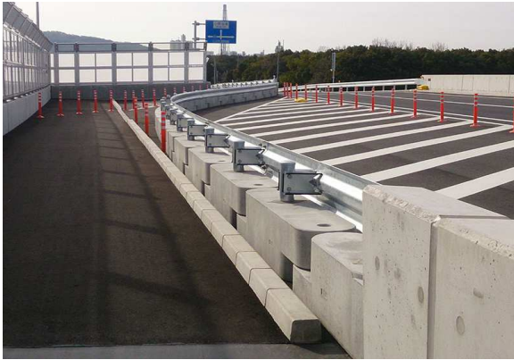
一般県道妻崎開作小野田線第6工区（置き式） 山口県 宇部土木建築事務所
