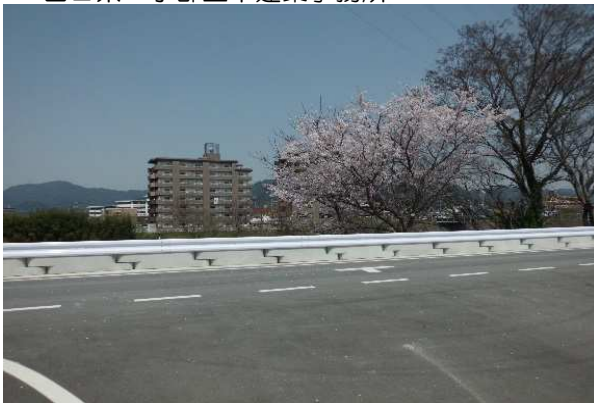
平井西岩屋線（置き式） 山口市役所
