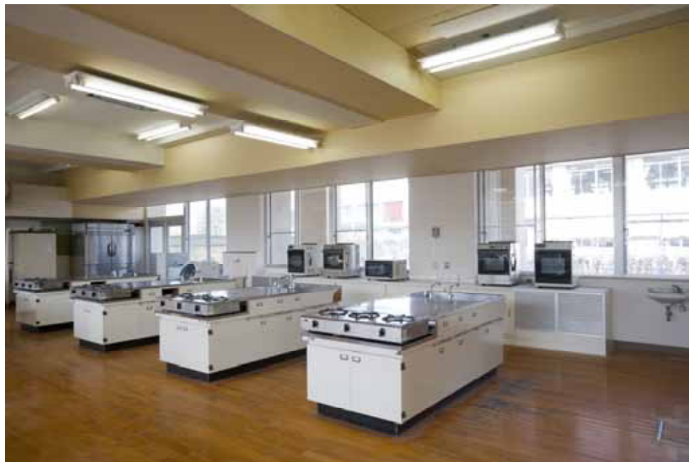
施工後 (室内側)
