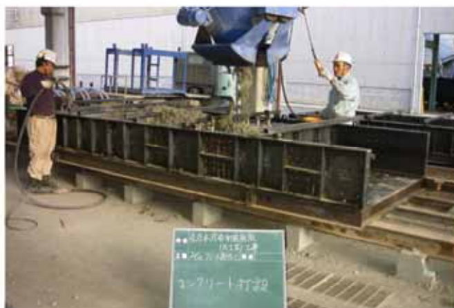
コンクリート打設状況
