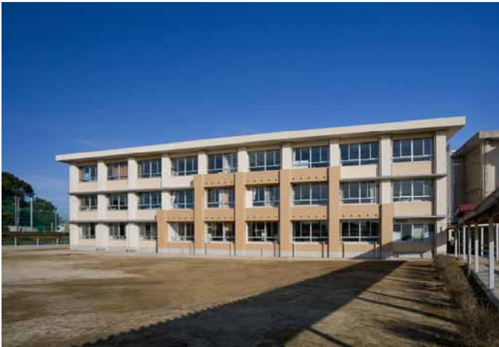
山口県内 某高校 平成21年 竣工 施工後 (南 面)
