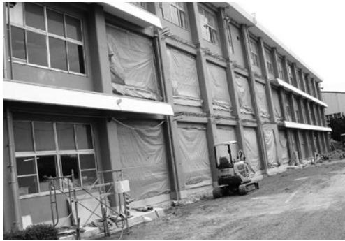
耐震改修前(S中学校)
