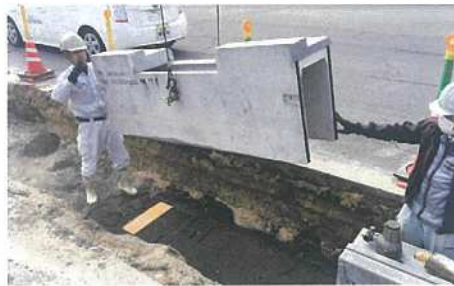
本体据付け状況
