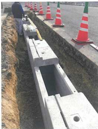
本体据付け完了
