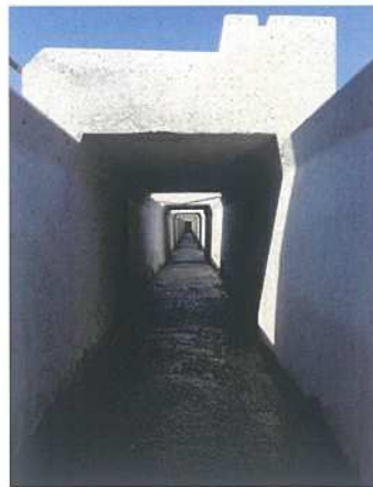
インバートコンクリート打設
