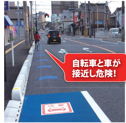
車道混在・付加車線で狭くなる交差点
