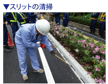
スリットの清掃は、工具を使用して行います。(※高圧洗浄による清掃も可能)
