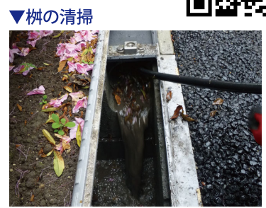
柵に集まってきたゴミは、工具を使用して清掃します。
