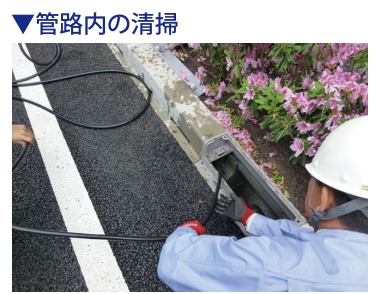
縁石柵から高圧洗浄機で清掃します。
