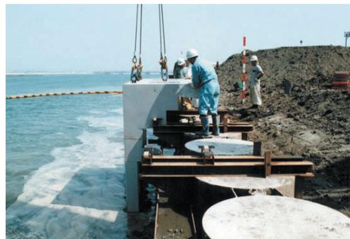
2.受台（H鋼）設置（溶接固定）
