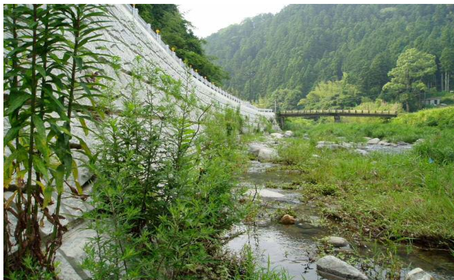
奈良県伊賀県民局 県単局部改良工事 前深瀬川
