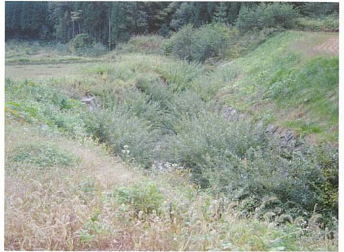
岐阜県稲越川最上流 (施工後4年)
