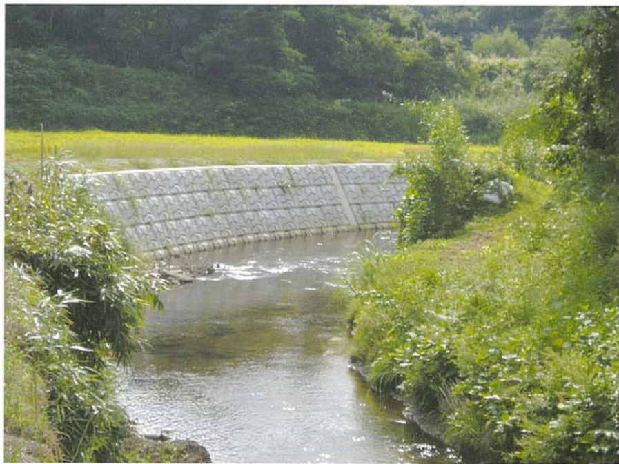
新潟県百川 (施工直後)
