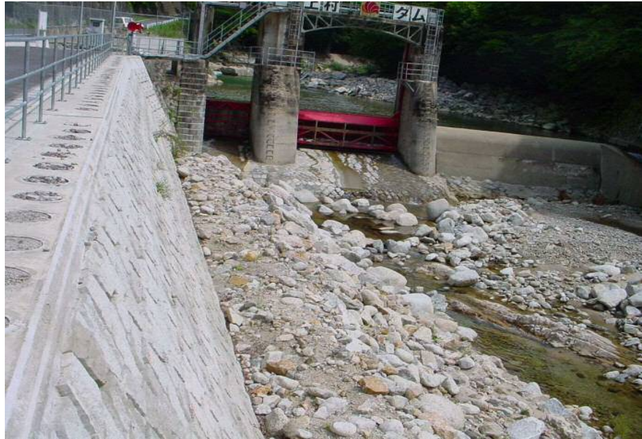
長野県 国土交通省 河川災害復旧工事 上村川
